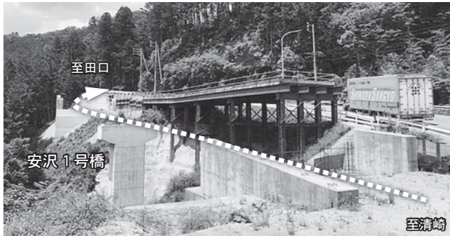
①国道257号 清崎 D2(安沢坂) ・道路の線形を緩やかにするため、橋梁工事を進めています。今後、上部工を施工する予定です。
