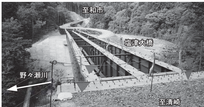
⑤和市清崎線 清崎 D22-2(塩津大橋) ・野々瀬川に架かる塩津大橋です。今後、この上に鉄筋コンクリートの床板を造った後、舗装します。
