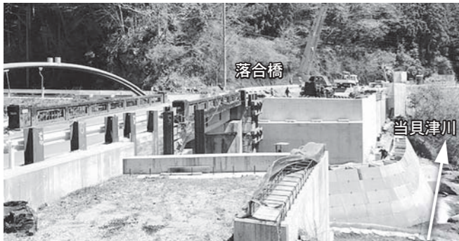
③国道420号 豊邦 D8(落合橋) ・現道を通行させながらの工事であり、まずは1車線分の橋梁の上部工を架設します。
